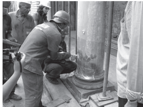
Figura 14 – Injeção de resina
