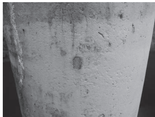
Figura 15 – Coluna do claustro após reforço estrutural
