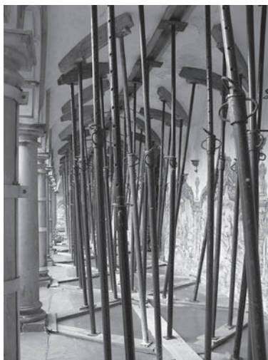
Figura 13 – Escoramento das arcadas e abóbadas de aresta do claustro
