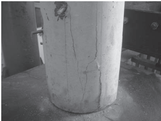
Figura 12 – Fissuras apresentadas pelo corpo de prova com passo de 45 cm no ensaio à compressão axial
