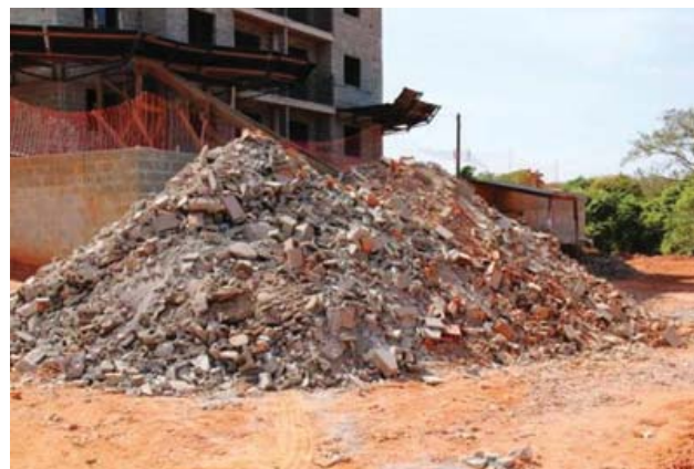
Figura 3: Canteiro de obra Fonte: Google
