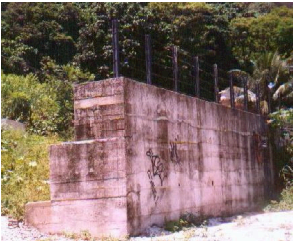
Figura 2 – Muro de concreto ciclópico – Fonte: UERJ
