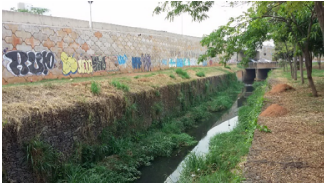
Figura 8 – Via expressa NS executada em terra armada
