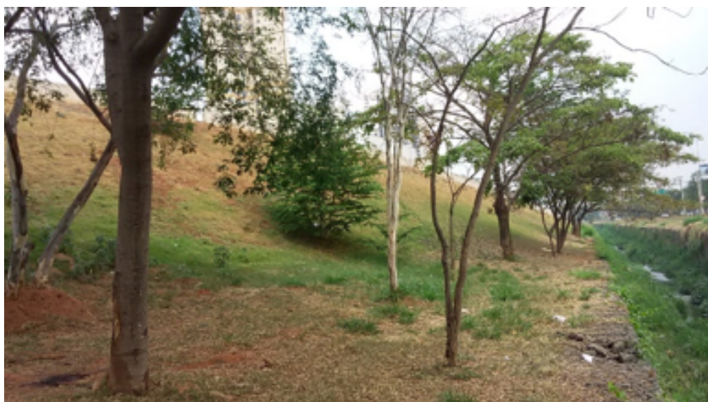
Figura 7 – Aterro da via expressa SN
