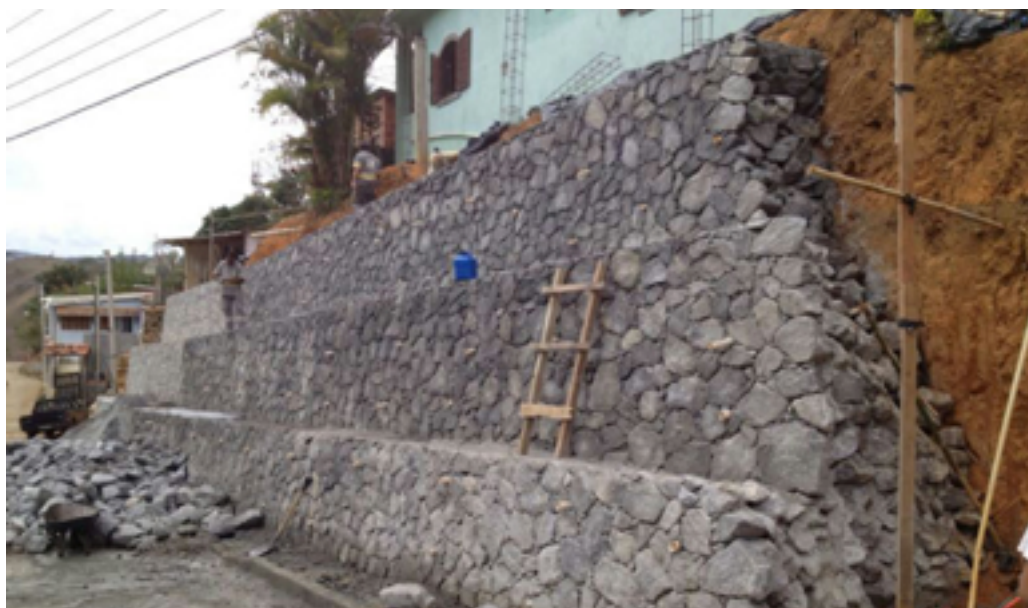
Figura 3 – Muro de Pedra argamassada – Fonte Prefeitura de Rio Claro (2013)
