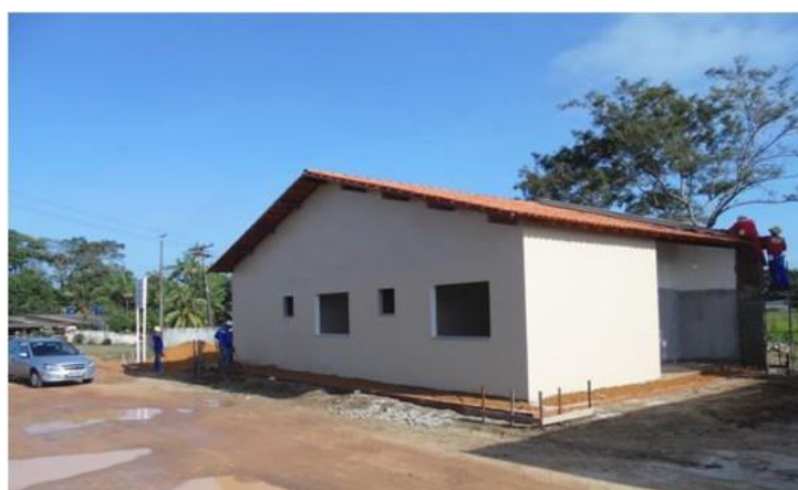
Figura 4: Unidade residencial em fase final de acabamento
