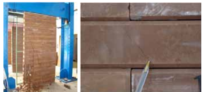
Figura 11 – Ruptura da parede P1 e primeiras fissuras nos tijolos.
