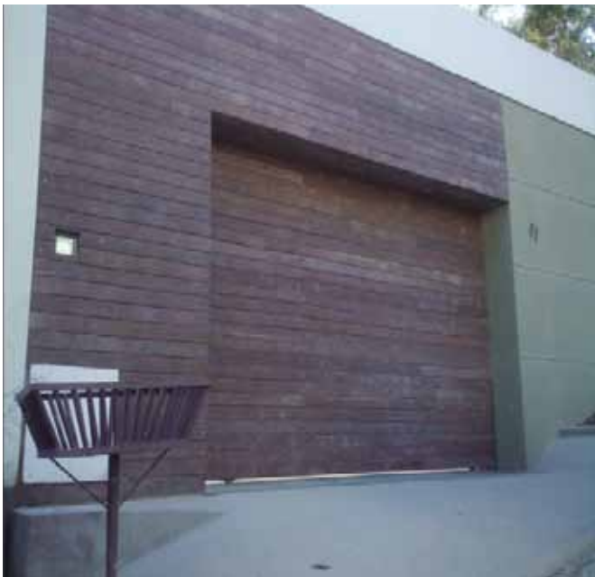
Figura 3 - Deck e revestimento de fachada de madeira bio sintética – imagens cedidas pela empresa Ecoblock
