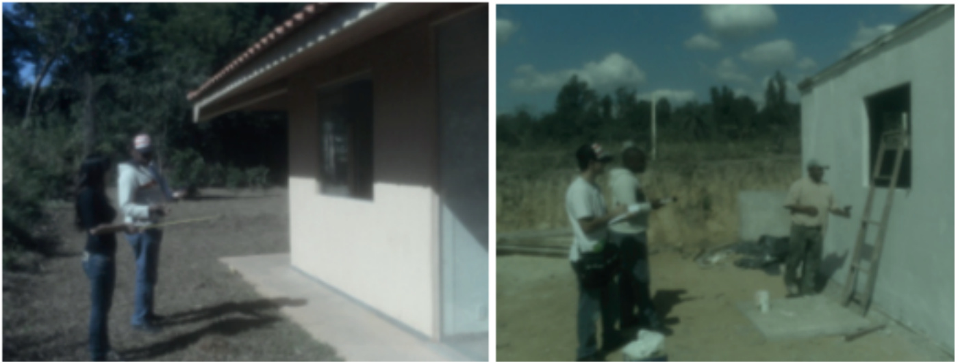
Figura 5 – Medições acústica feita na casa de concreto e no cotainer.
