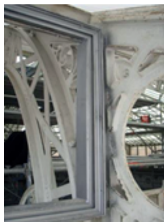
Figura 9: Aplicação de caixilharias exteriores nos lanternins de iluminação/ventilação.
