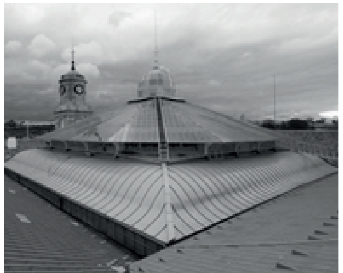
Figura 7: Cobertura envidraçada do Pátio das Nações – antes e depois da intervenção.
