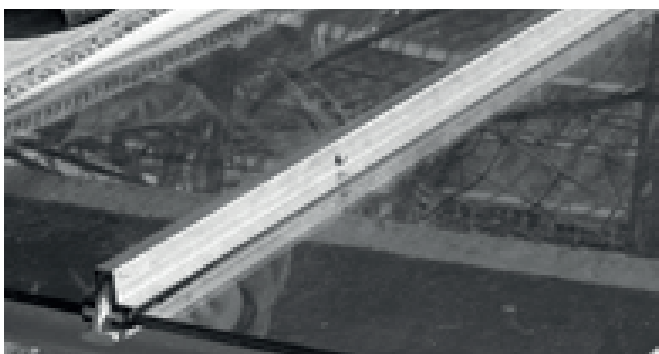
Figura 6: Tratamento da cobertura envidraçada do Pátio das Nações.
