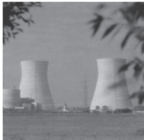
FIGURA 18 – Central Nuclear de Grafenrheinfeld, Alemanha Hiperbolóide como sup. regrada
