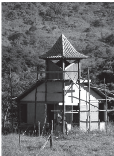
Figura 7 - A capela em fase de acabamento, no mês de maio (Silveira, 2010)
