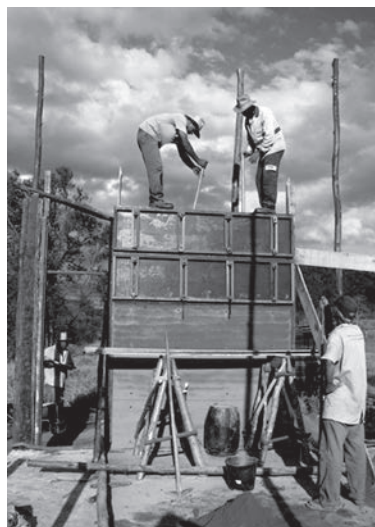
Figura 5 – Construção da parede de taipa de solo-cimento (Silveira, 2009)
