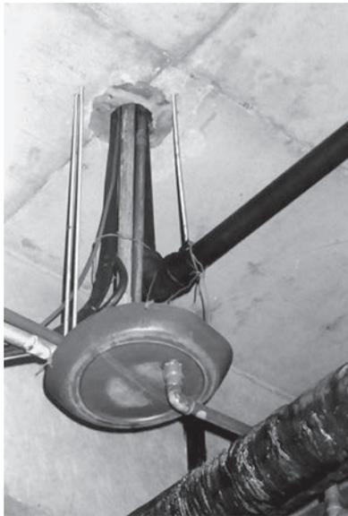
**Foto 4: Suporte instalado para conduzir a água proveniente de uma infiltração da laje**
