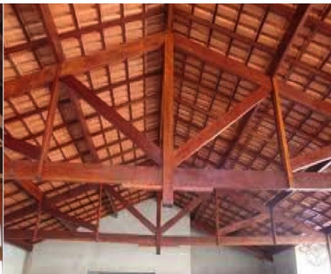
**Figura 2** - Vista de uma tesoura tipo howe em paraju
