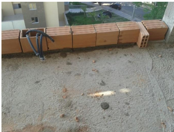
Figura 6 – Marcação de alvenaria
