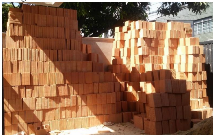
Figura 3: Armazenamento dos blocos cerâmicos
