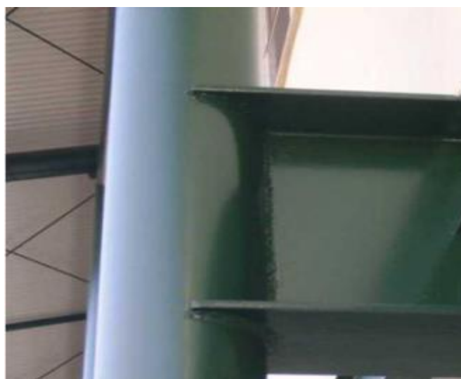
Figura 1: Exemplo de ligação entre viga de seção I e pilar tubular circular
