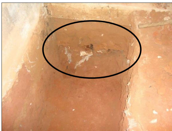
FIGURA 2: Escavação do terreno
