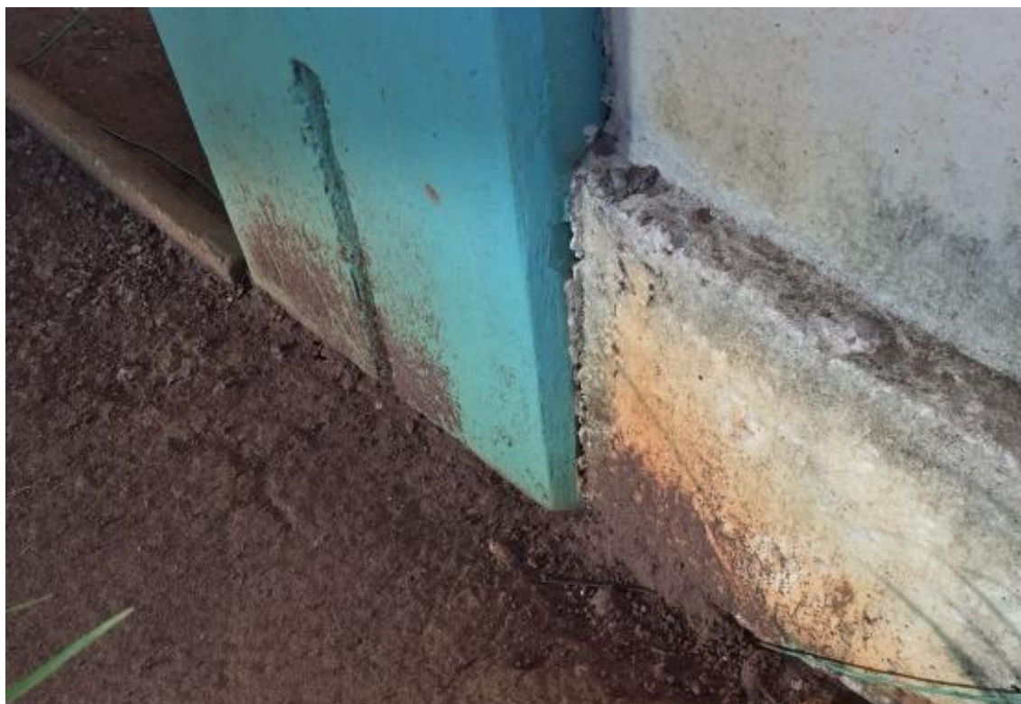
Figura 4: Parte inferior da parede frontal externa
