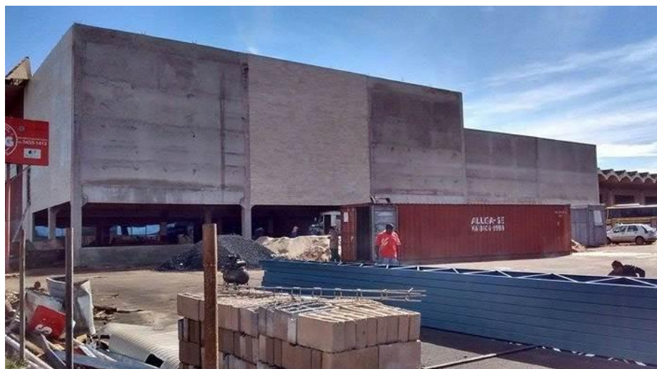
Figura 03 – Obra nos acabamentos em maio de 2017.
