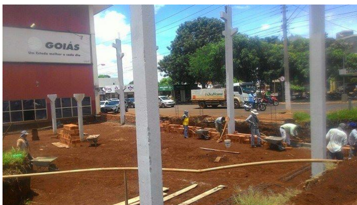
Figura 01 – Superestrutura de pré-moldados.
