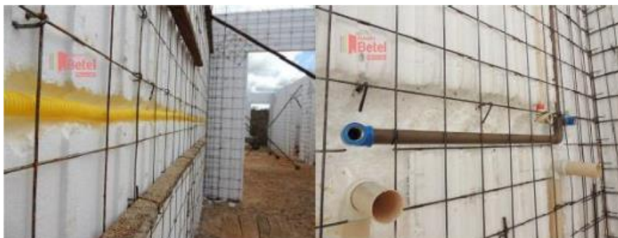
Figura 6 – Instalação de condutos hidráulicos e elétricos no sistema monolítico em EPS
