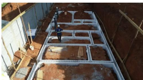
Figura 14 – Utilização de canaletas em EPS
