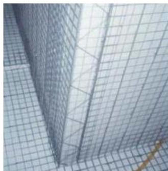
Figura 5 – Malha de aço sobreposta ao EPS
