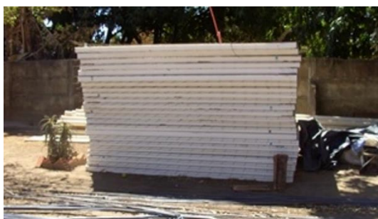
Figura 15 – Empilhamento de painéis de EPS
