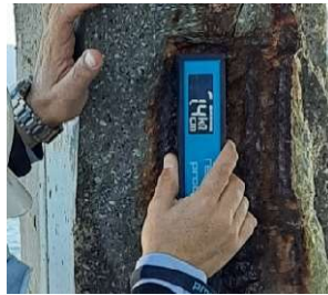
Figura 6 - Exemplo de estrutura submetida a ensaio para medir a resistividade elétrica
