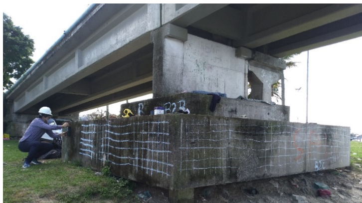
Figura 16- Marcação da ferragem do bloco no continente através da pacometria
