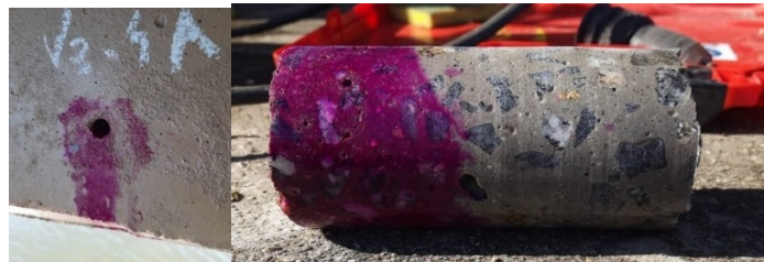
Figura 20 - Medição de profundidade de carbonatação
