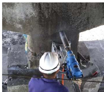
Figura 22- Extração de corpo de prova para ensaio
