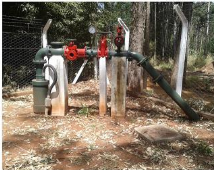
Figura 2: Poço tubular estudado - aspecto externo.
